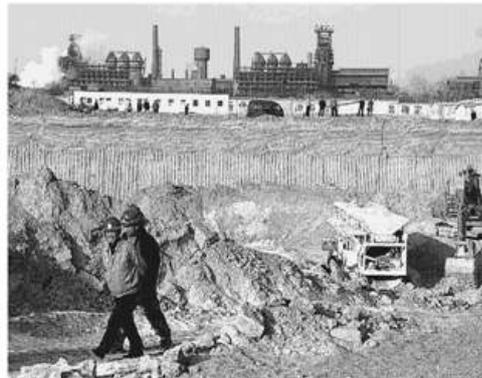
中国山西省臨汾市で進む発電所の建設工事。背後の製鉄所など2力所で排出される高炉ガスを利用して発電する—6日、鈴木均子撮影
